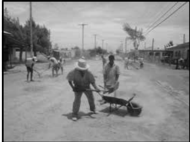
Asfalto começa a ser colocado na Av. Calábria.
